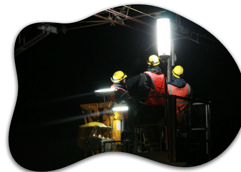
Construction : travaux sur voies ferrés
