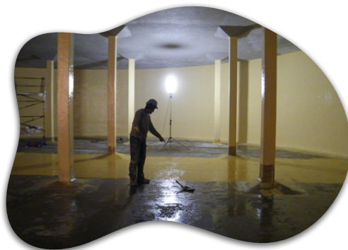
Revêtement surface dans un château d'eau
