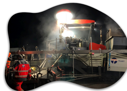
Travaux de route, installation sur Finisher
